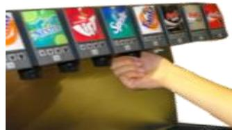
Insertar los difusores en cada una de las válvulas de la torre de gaseosas.
