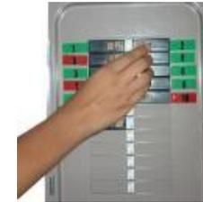
Apagar los interruptores de energía eléctrica que correspondan a las luces, plasmas, puntos de venta y Taquilla automática de acuerdo a la etiqueta que se encuentra en la puerta del gabinete o cerca de él. No se deben apagar los interruptores correspondientes al sistema. Por ningún motivo se debe dejar la puerta de los interruptores abierta.
