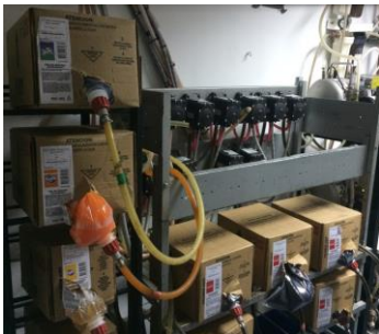
Sistema de mangueras para Bag in Box de jarabe de gaseosa
