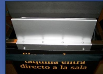
Instalación de la base metálica en la Arquilla.
