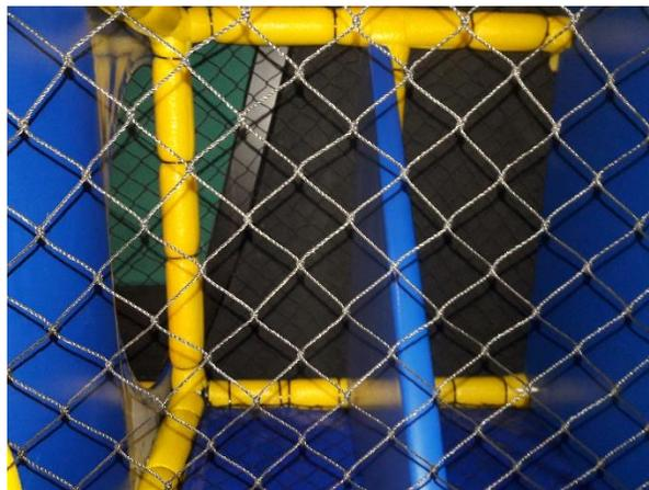
7. Inspeccionar se a espuma de revestimento não está deteriorada, muito menos rasgada:
