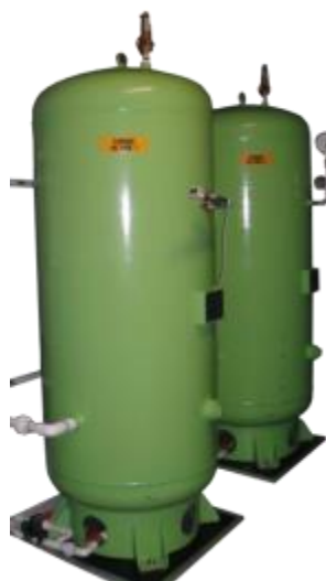
Tanques de ar (para 4DX)
