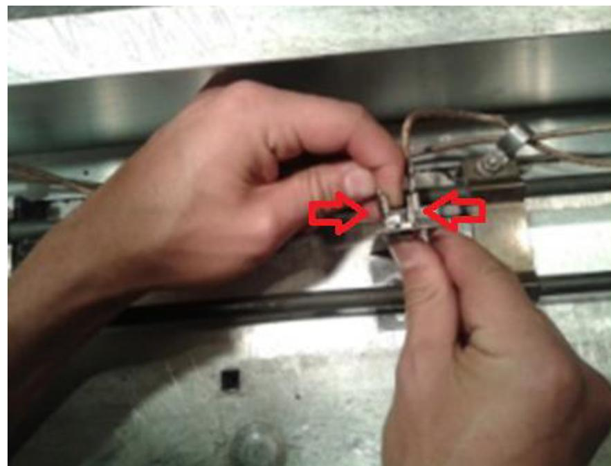
**Passo 9:** Fixe o novo termostato para a base, este deve ter um cinto para ser fixado.
