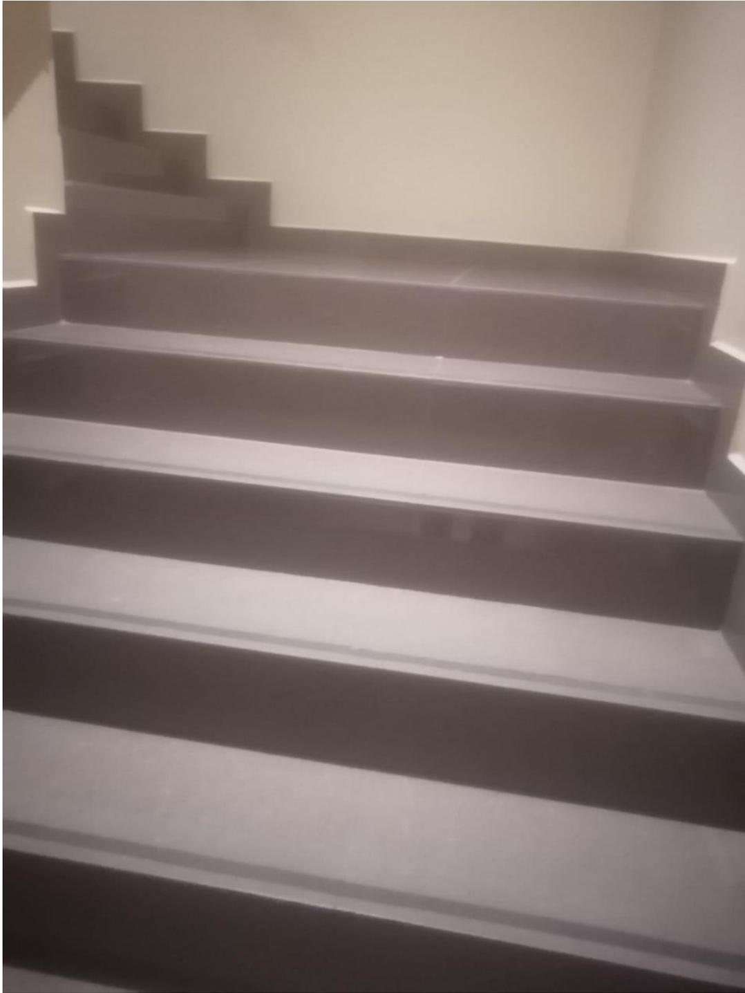
Se pegan puntas despegadas y se cotizara material para cambiar los escalones mas dañados
